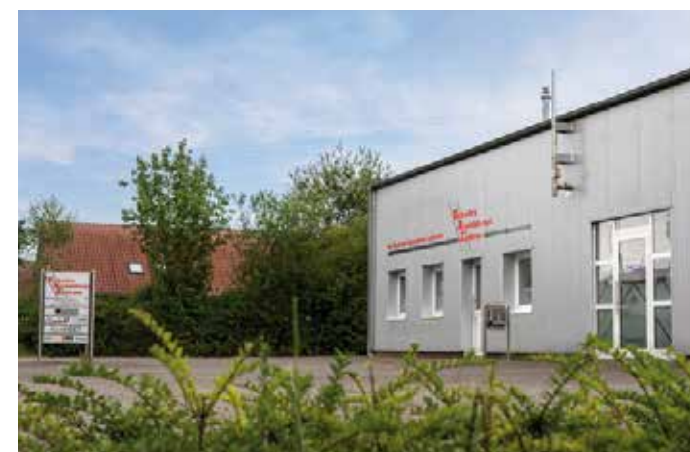
Die VAZ in Cloppenburg-Emstekerfeld
